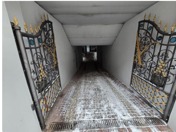
lebrauktuve ēkas pagalmā no Ausekļa ielas
